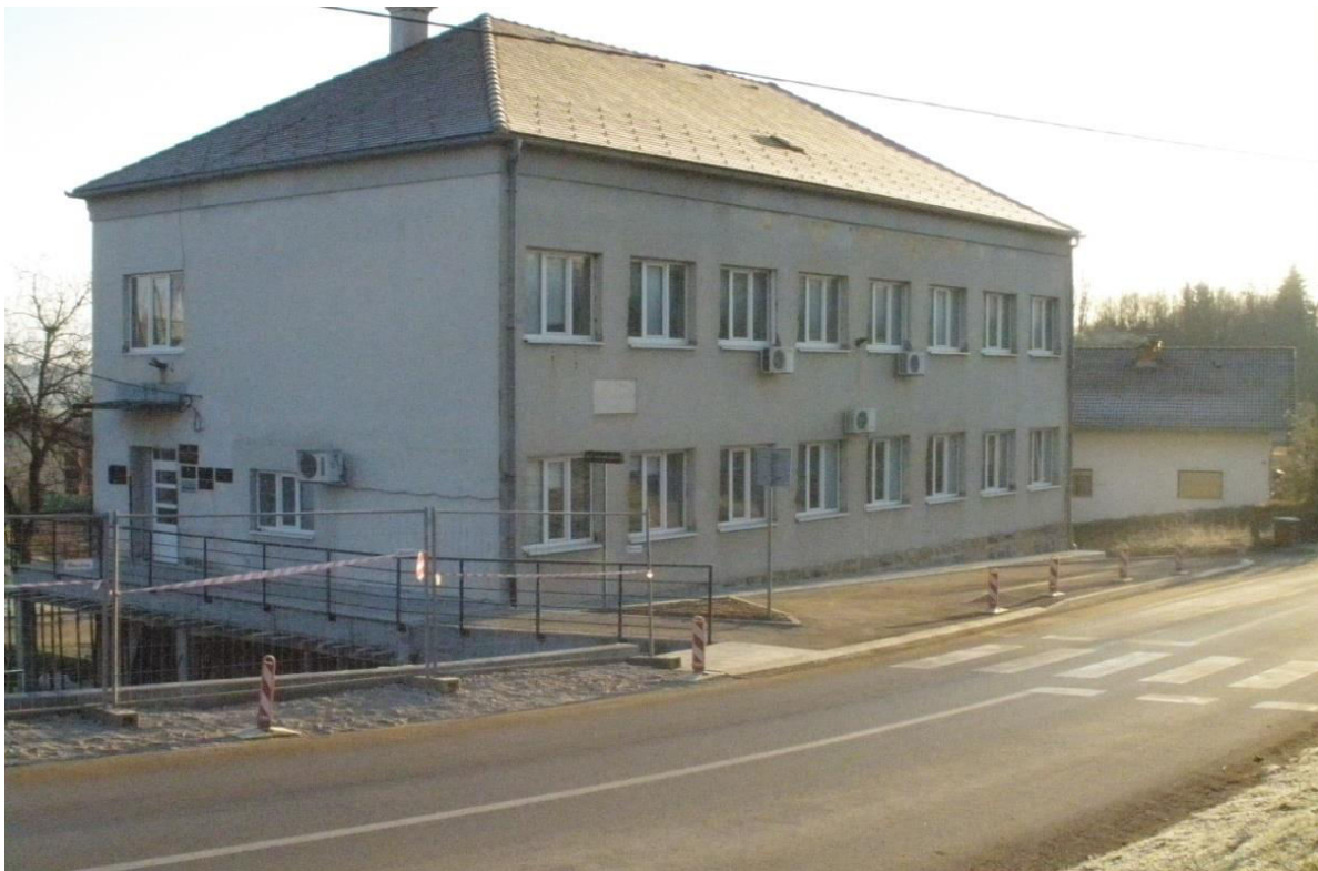
Javna zgrada kbr. 15, dvorište i zemljište za sport i rekreaciju u Ozlju, Zrinskih i Frankopana 15, sagrađena na kč.br. 2093 k.o. Ozalj
