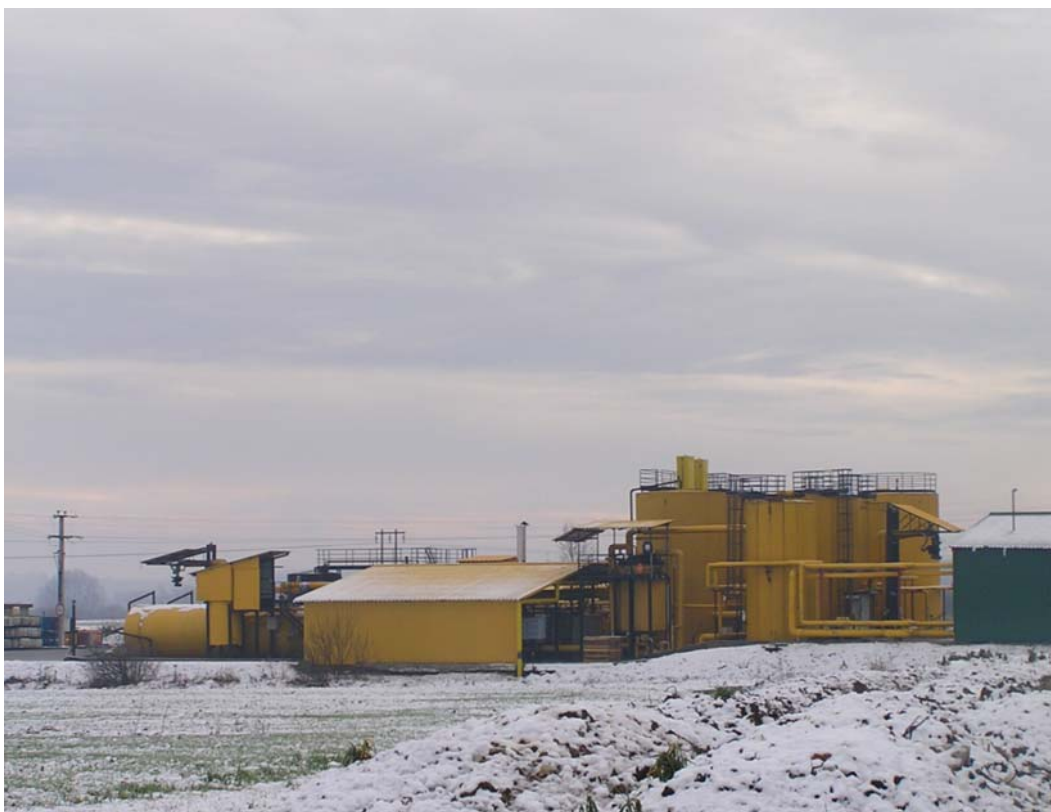
Pogon za proizvodnju polimernog bitumena MODIBITA
